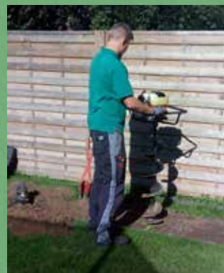
ERD- & BETONARBEITEN BEI PUNKTFUNDAMEN- TEN (AUFPREIS)
